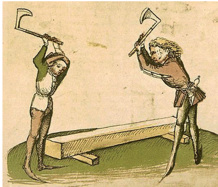
Zimmerleute bei der Arbeit.
